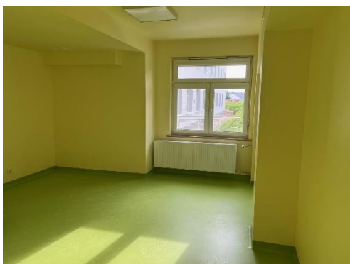
Zdjęcie nr 6: remont - oddział
