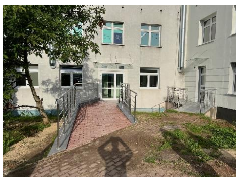
Zdjęcie nr 4: przebudowa wejścia do Kliniki Pediatrii
